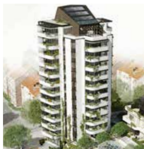
De særlige "næser" på Greenhouse, som er 860 mm. Der er 3 altaner på hver etage og en næse på hver side af altanen.
