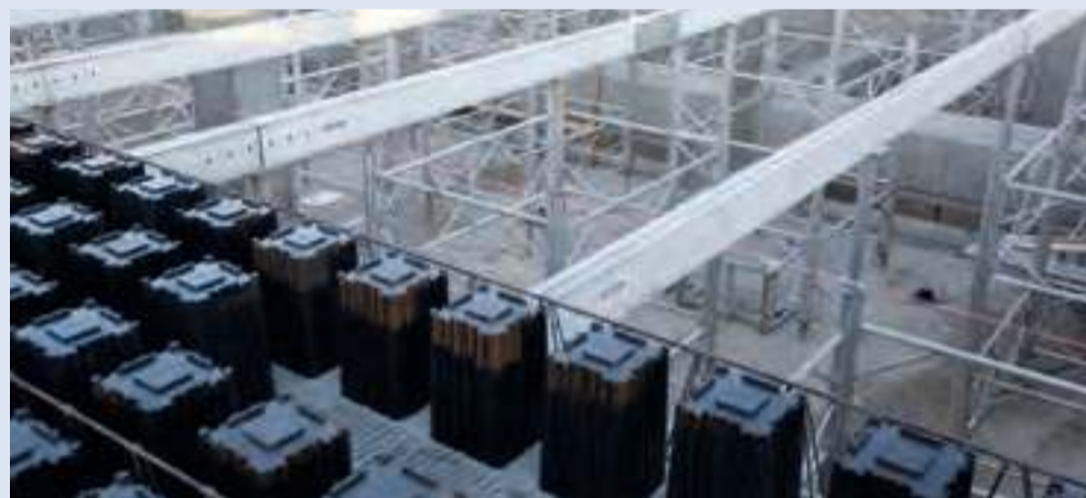
AirDeck på vandtanken i Viborg.
