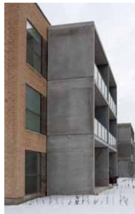
En iøjnefaldende detalje ved byggeriet er altanelementerne i beton, som er monteret uden på selve huset.
