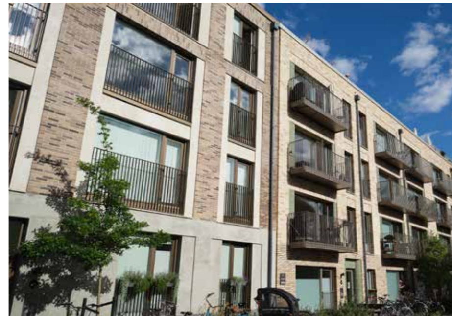
BYGGEFELT 16.3 Rahbek Hus II Entreprenør HHM A/S Ingeniør Alectia A/S Arkitekt Praxis Arkitekter ApS
