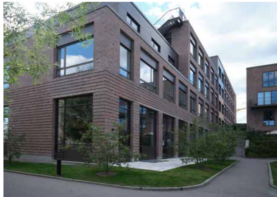
BYGGEFELT 16 Bindebøll Hus Entreprenør HHM A/S Ingeniør Alectia A/S Arkitekt Praxis Arkitekter ApS
