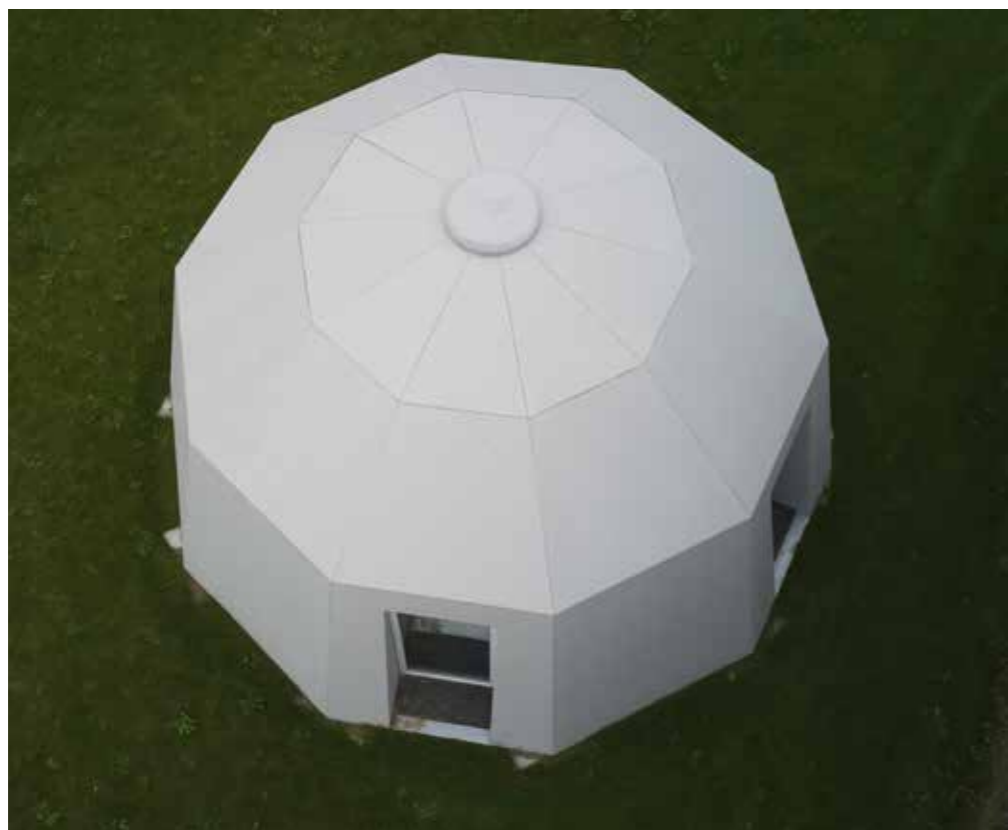
Hus-igloen består af 31 plader støbt i fiberbeton. Samlet vægt efter montage er ca. 5 ton.
