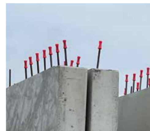
De røde plastpropper øger sikkerheden på byggepladsen, og samles bagefter ind og genbruges.
