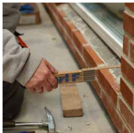
Vinduer kontrolmåles i forbindelse med kvalitetskontrollen.
