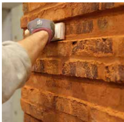
Murværket afrenses umiddelbart efter opmuring.
