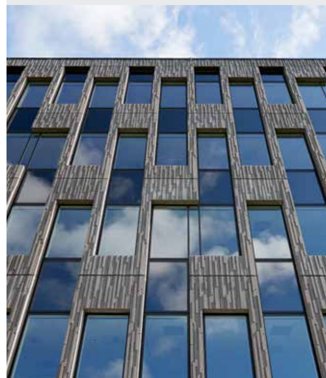
EG DOMICIL, BALLERUP Smukke relieffer i antracitgrå facadeelement bryder ensartet overflade.
