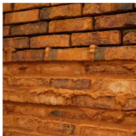
Murværket fuges fra fabrik. Indfarvede fuger, som matcher murstenen, er også en mulighed.
