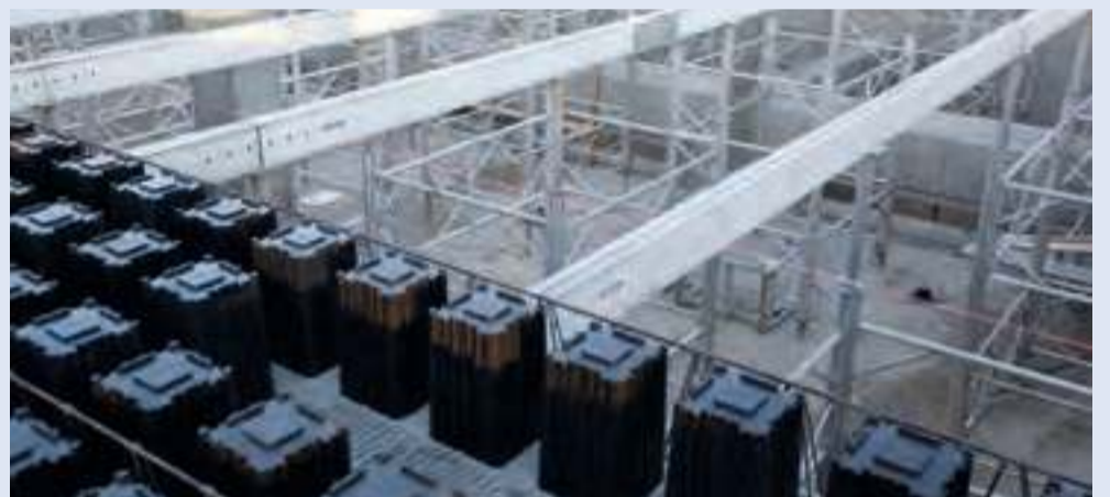
AirDeck på vandtanken i Viborg.
