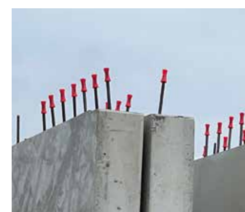
De røde plastpropper øger sikkerheden på byggepladsen, og samles bagetter ind og genbruges.
