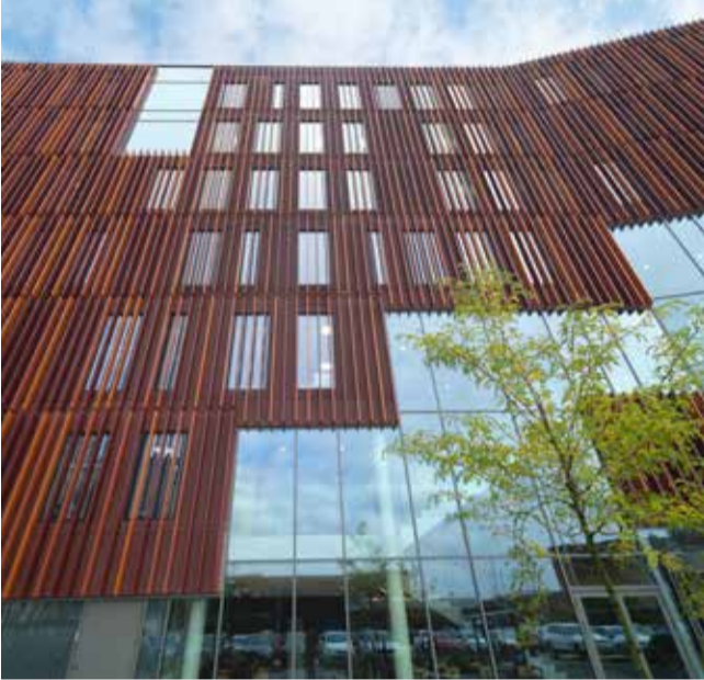
IBA, KOLDING Afsyrede røde indfarvede sandwichfacader beklædt med alu-lameller i orange og rødlig nuancer.
