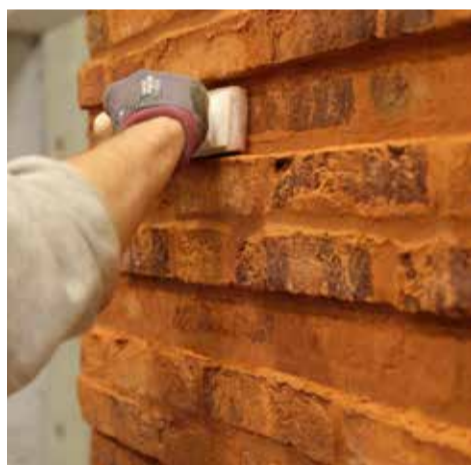
Murværket afrenses umiddelbart efter opmuring.
