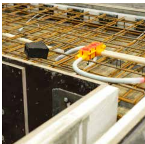
Murstensfacadeelementer leveres med rørføringer for el, ventilation mm.
