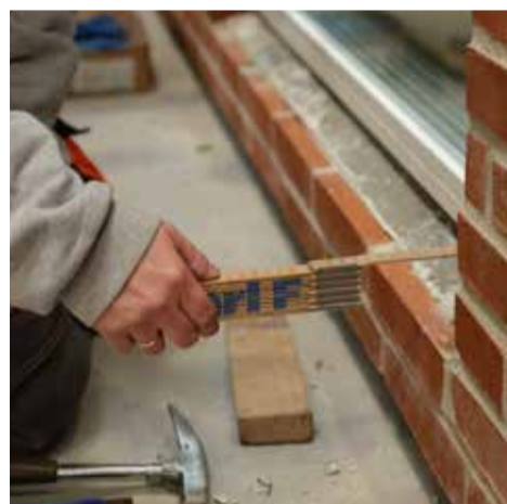
Vinduer kontrolmåles i forbindelse med kvalitetskontrollen.
