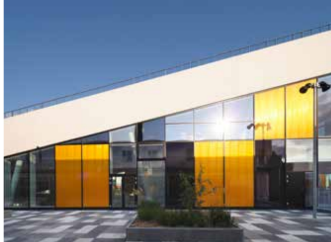
TEKNISK SKOLE, SILKEBORG Flotte hvide sandwichelementer i rå look krydret med mosaik i varm orange og lysende glas.
