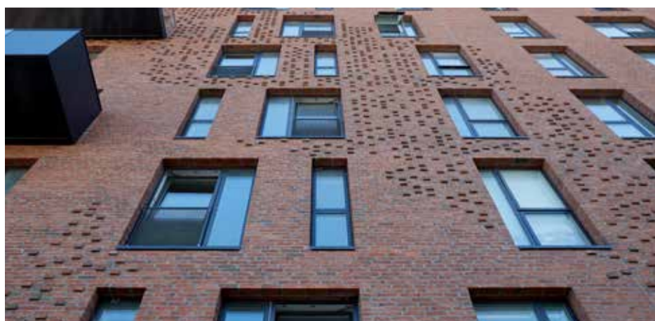
Et særpræget spil i facaden er opnået ved at trække kopper ud i særligt mønster.
