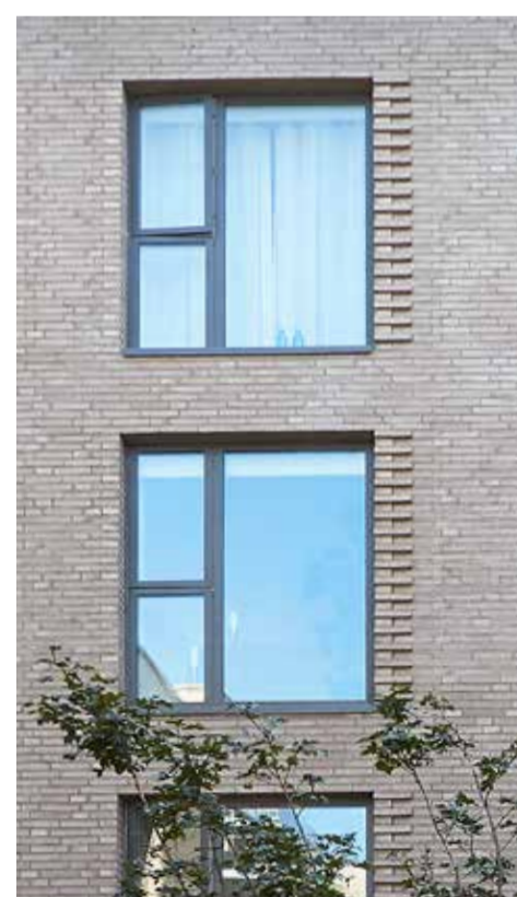
Flot detalje rundt om vinduesåbninger.
