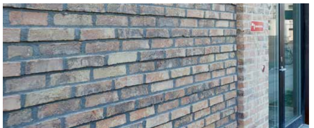
Samme mursten er brugt til facaden – men to forskellige fugefarver giver et flot spil. Samtidig er hver anden mursten forskudt, så der dannes et flot bånd
