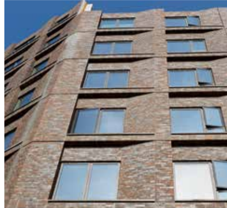
Facadeelementer leveret med mursten – opmuret på vores fabrik.
