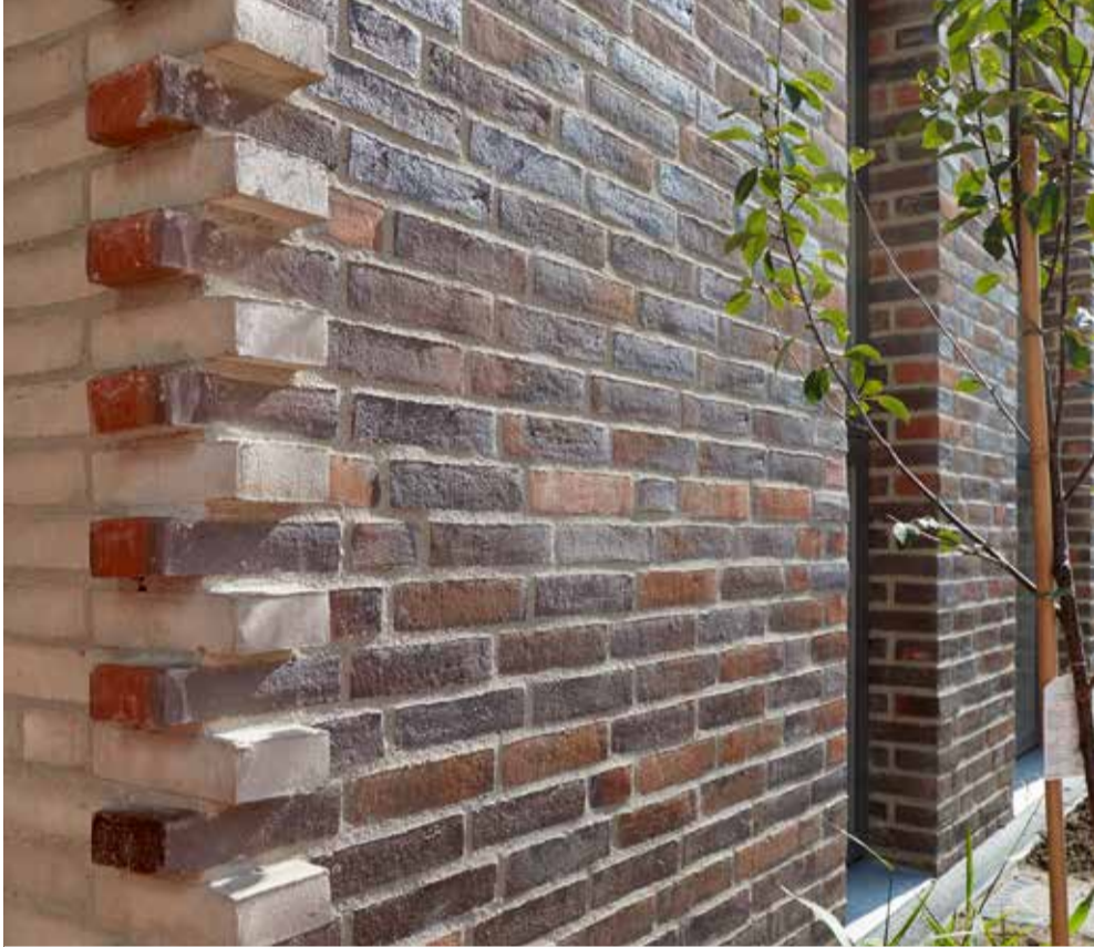
Interessant samling af to forskellige mursten.
