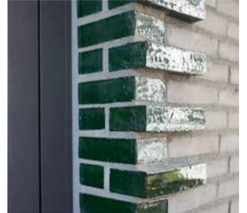
Glaserede mursten brugt som afslutning ved døråbninger.
